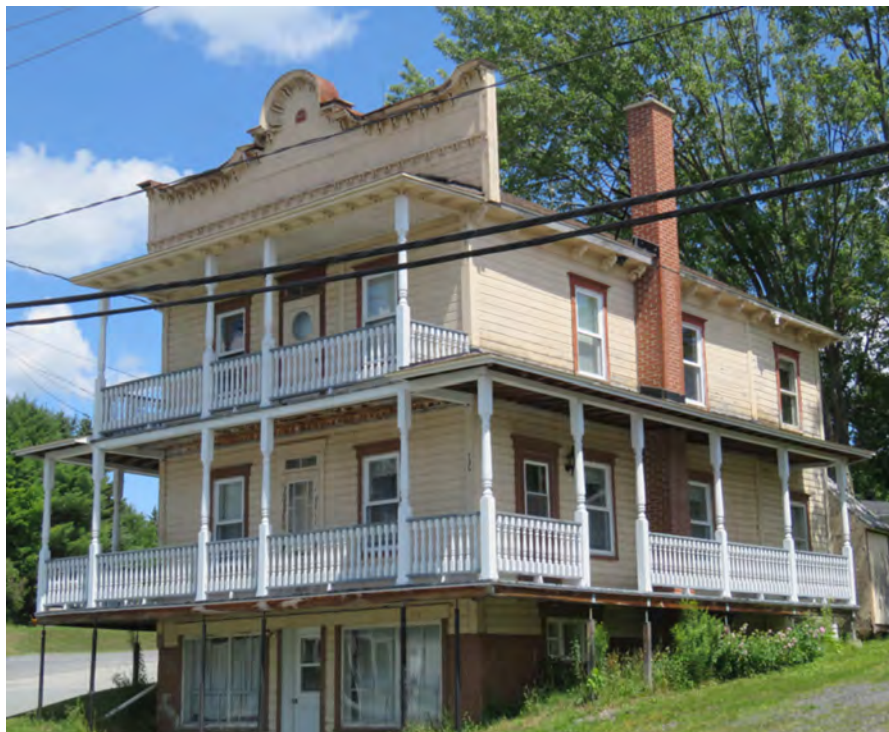
Extrémité du mur parapet orné de consoles doubles découpées. img_0541-C.jpg
