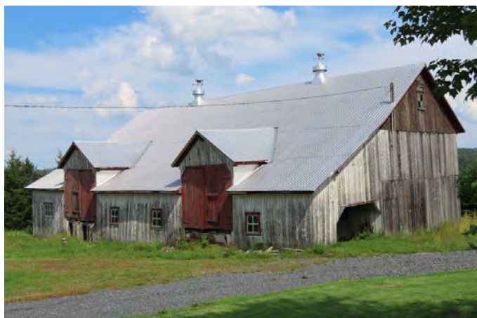
Imposante grange au toit à versants asymétriques avec lucarnes monumentales au 390, route 271 Sud, Saint-Éphrem-de-Beauce. IMG_1697K.jpg
