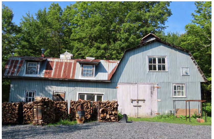
Cabane à sucre au toit à « versants brisés », dotée d'un corps secondaire, située au 148, 7 e Rang Sud, Saint- Ephrem-de-Beauce. IMG_1558K.jpg
