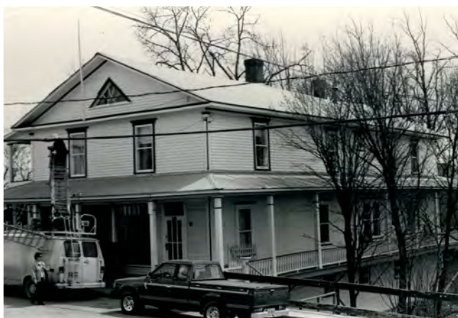
Le 1316, rue Principale, Saint-Côme– Linière, aujourd'hui démoli. Photo : Inventaire de 1984, MRC de Beauce-Sartigan.
