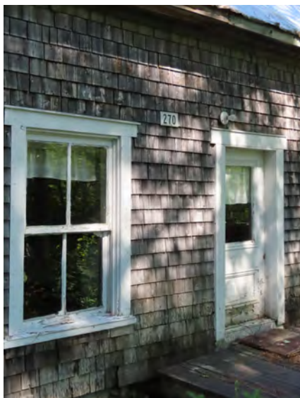
Fenêtre à guillotine à grands carreaux et porte à panneau et vitrage. 270, rang des Plaines, Saint-Évariste-de-Forsyth. IMG_1323K.jpg
