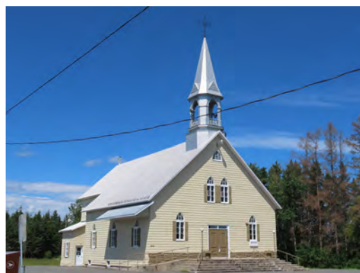
Architecture religieuse : l'église de Saint-René. 824, route Principale, Saint-René. IMG_4308-L.jpg
