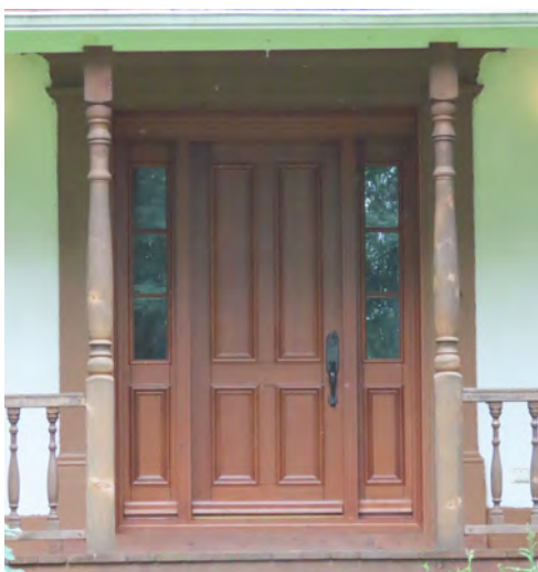
Porte en bois massif, à panneaux et à baies latérales. Manoir William-Milburn-Pozer, 601, avenue de la Chaudière, Saint-Georges. IMG_1431K.jpg
