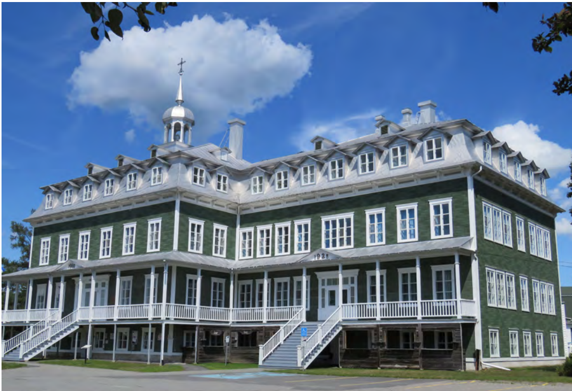
Ancien couvent des Sœurs de la Charité de Saint-Louis, seul édifice en son genre dans la MRC. 127-A, 1 re Avenue Sud, Saint-Gédéon-de-Beauce. img_0622-C.jpg
