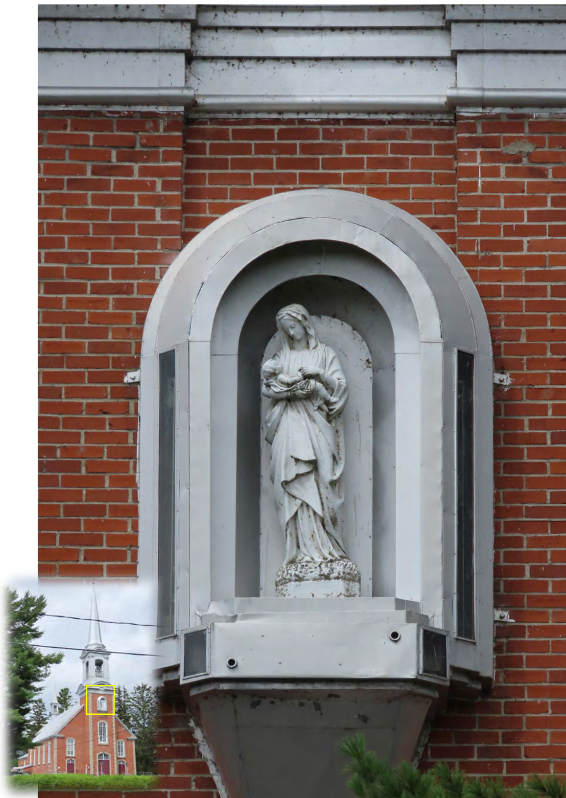
Niche avec une Vierge à l'Enfant, lovée sous la base du clocher de l'église Notre-Dame-de-la-Providence. 2760, 1 re Avenue, Notre-Dame-des-Pins. IMG_0913K.jpg
