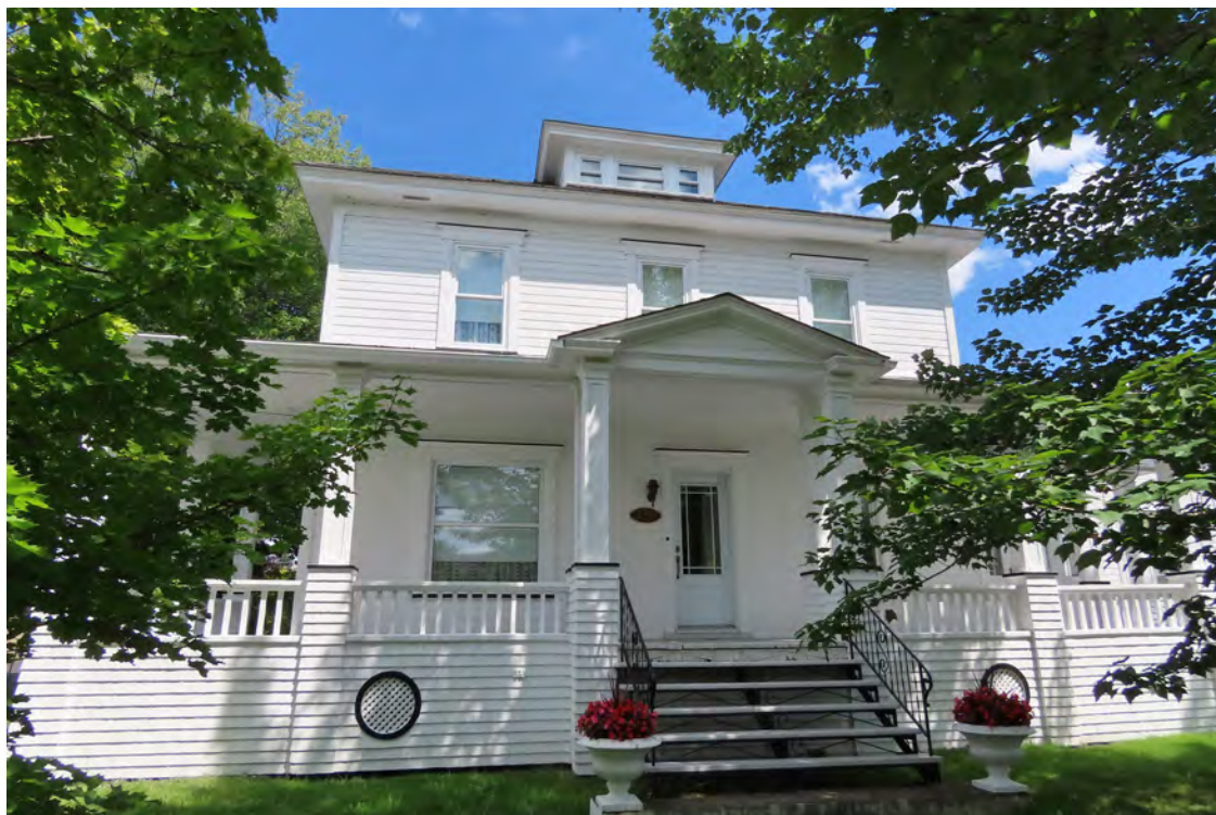
Le 135, 1 re Avenue Est, Saint-Martin, un édifice à valeur patrimoniale forte. IMG_0879-K.jpg
