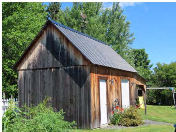
Bâtiment secondaire à usage domestique à revêtement de planches verticales. 10, avenue du Pont Ouest, Saint-Martin. IMG_4298-L.jpg
