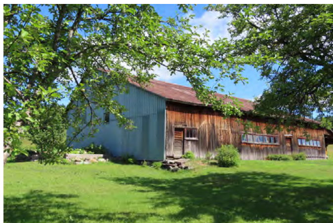
Grange située au 287, route 271, Saint-Benoît-Labre. img_0371-K.jpg
