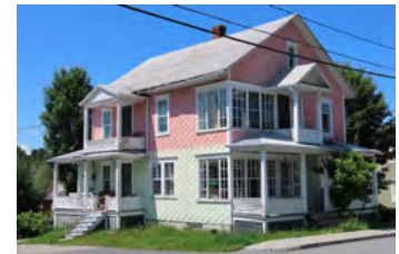
1344, rue Principale, Saint-Côme-Linière
