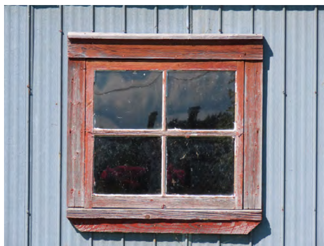
L'une des fenêtres fixes à carreaux, en bois, au rez-de-chaussée de la grange-étable ci-contre. IMG_4790-L.jpg
