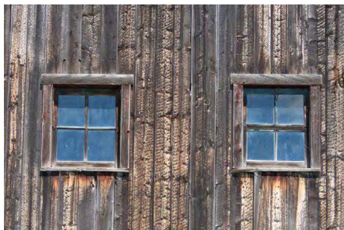
Fenêtres fixes à petits carreaux, avantageusement conservées sur une grange-étable. Il en est ainsi pour le revêtement de planches verticales. 35, route 271, Saint-Benoît-Labre. img_0431-K.jpg
