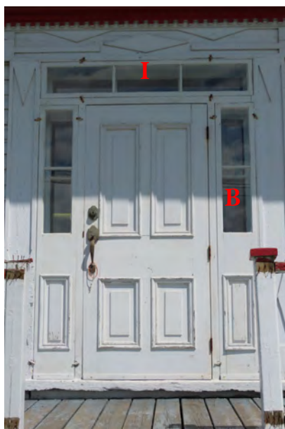
Autre modèle de porte en bois massif à panneaux et à baies latérale (B). La porte est surmontée d'une imposte (I) à carreaux. 3815, route du Président-Kennedy, Notre-Dame-des-Pins. IMG_0970K.jpg
