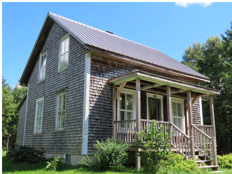
Un des rares édifices encore revêtus de bardeau de bois : le 877, rue Principale, Saint-Hilaire-de-Dorset. IMG_4825-L.jpg
