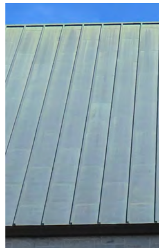
Tôle à baguettes sur le presbytère de L'Assomption-de-la-Bienheureuse-Vierge-Marie, 12375, boulevard Lacroix, Saint-Georges. IMG_3611-C.jpg
