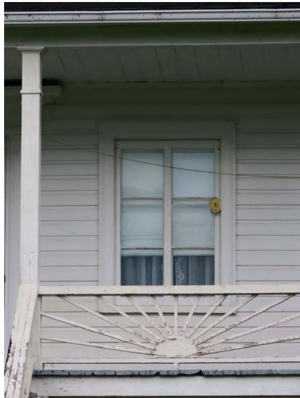
Garde-corps dont les barreaux sont constitués de motifs épousant la forme de rayons. 3180, chemin Royal, Notre-Dame-des-Pins. IMG_4483L.jpg
