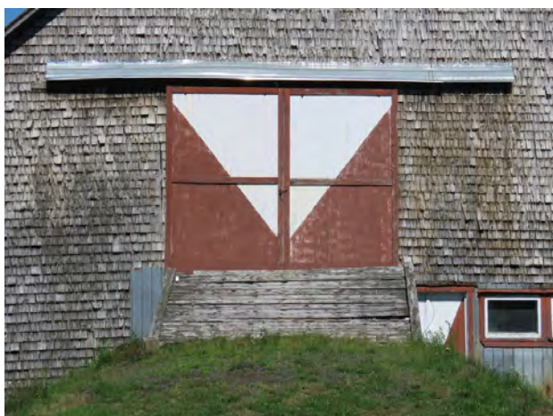
Porte à doubles battants sur la grange-étable du 956, route 108 Ouest, Saint-Éphrem-de-Beauce. img_0324-C.jpg
