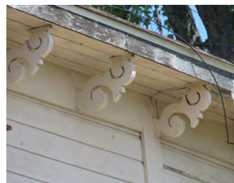
Consoles découpées ornant l'avant-toit aux murs latéraux. img_0534-C.jpg
