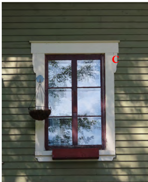
Chambranle découpé au 3205, 1 re Avenue, Notre-Dame-des-Pins. IMG_1000K.jpg
