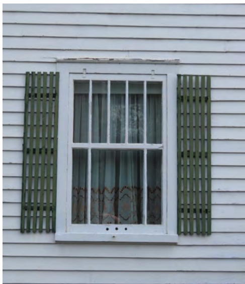
Contrefenêtre à petits-bois. 632, 17 e Rue, Saint-Georges. IMG_1391K.jpg
