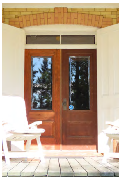
Porte à doubles battants surmontée d'une imposte et d'un arc surbaissé en brique. Manoir Taylor, 540, route Taylor, Saint-Simon-les-Mines. IMG_1064K.jpg
