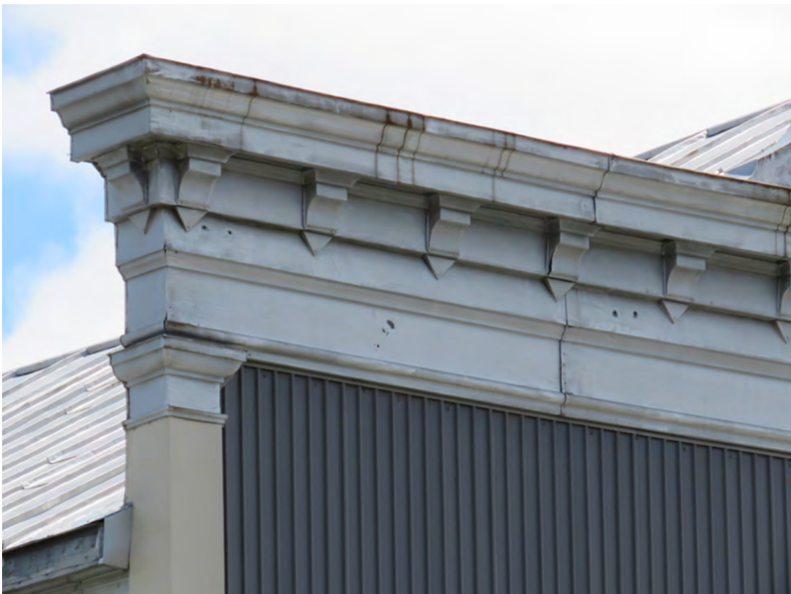
L'extrémité du mur parapet, formant une corniche métallique à consoles. img_0017-C.jpg
