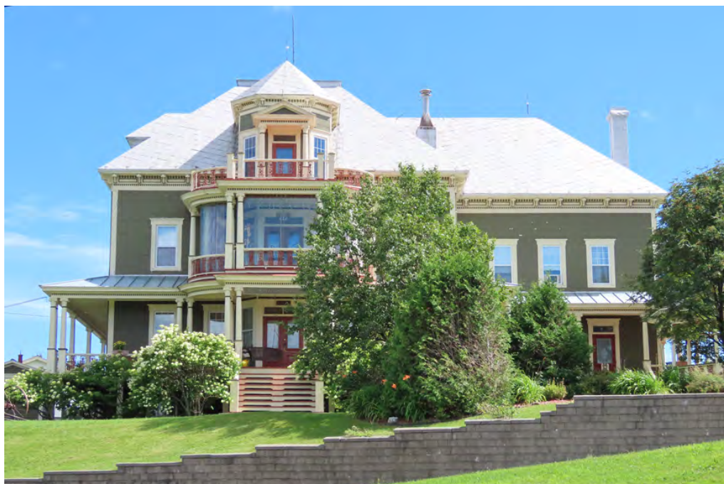
Ancien presbytère de Saint-Evariste-de-Forsyth au 325, rue Principale, un immeuble patrimonial classé. IMG_1290K.jpg
