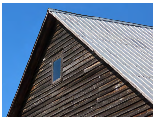
Revêtement de planche à clin observable sur le mur pignon du même bâtiment. IMG_4152L.jpg
