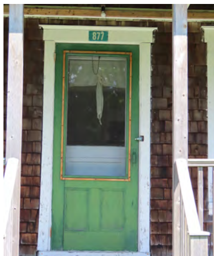
La porte moustiquaire en bois : une composante de plus en plus rare, 877, rue Principale, Saint-Hilaire-de-Dorset. IMG_4824-L.jpg
