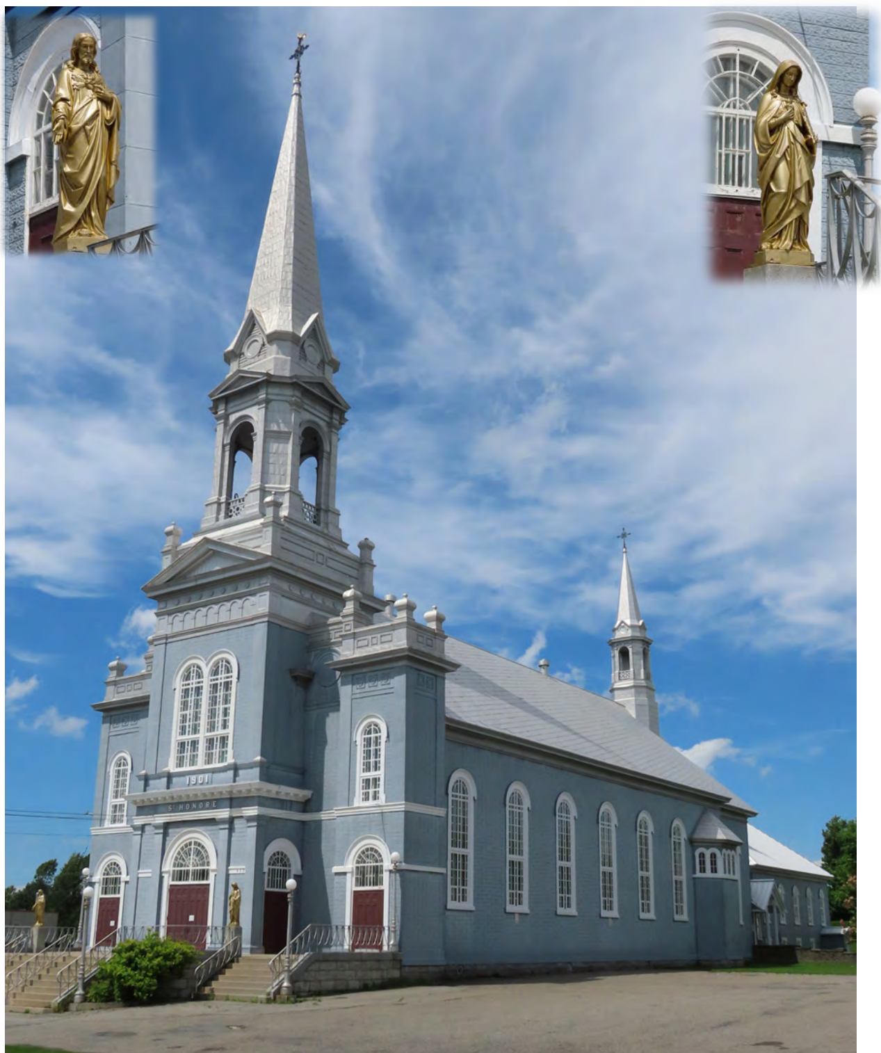
Eglise de Saint-Honoré, 449, rue Principale, Saint-Honoré-de-Shenley. Construite en 1901, selon les plans de David Ouellet, un architecte marquant en architecture religieuse au Québec à la fin du 19 e siècle et au début du 20 e siècle, l'église offre, selon nous, une valeur patrimoniale supérieure. En médaillon : statues du Sacré-Cœur et de la Vierge. IMG_0693-K.jpg
