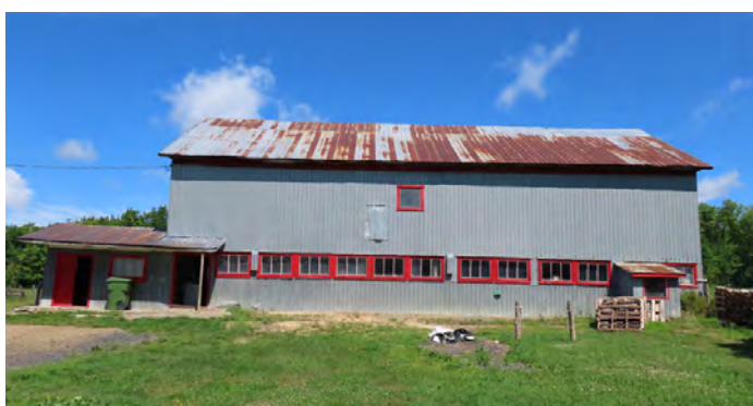
Fenestration typique d'une étable, formant un long rectangle horizontal, avec sa suite de rangées de fenêtres. 255, route 271, Saint-Benoît-Labre. img_3917-L.jpg
