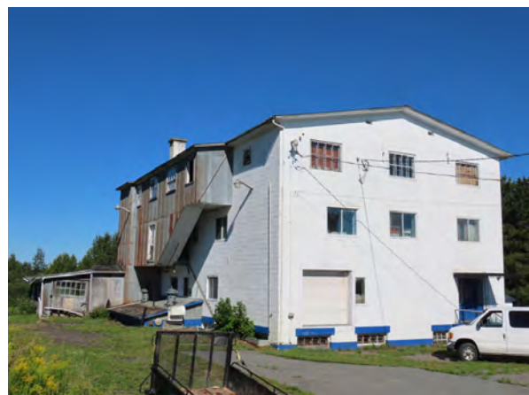
Edifice associé à l'architecture industrielle : une ancienne manufacture de couture. 470, rue Jobin, Saint-Honoré-de-Shenley. IMG_4727-L.jpg
