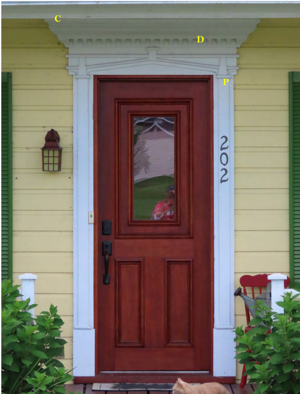
Porte à panneaux et vitrage, encadrée de pilastres (P) et d'une corniche (C), elle-même ornée d'appliches et de modillons (D). 202, 1 re Avenue Est, Saint-Martin. IMG_0893-K.jpg
