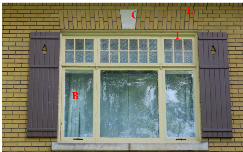
Contrefenêtre à six grands carreaux, devant des battants ouvrant par l'intérieur. 3175, chemin Royal, Notre-Dame-des-Pins. IMG_1005K.jpg
