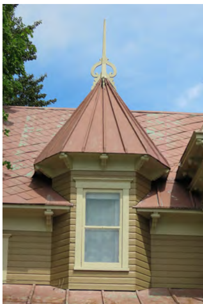
Lucarne à fenêtre pendante à toit pyramidal surmontée d'un épi et ornée de consoles. 351, rue Principale, Saint-Honoré-de-Shenley. img_0675-k.jpg
