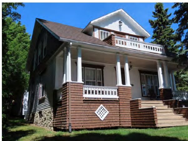
Le 12675, 2 e Avenue, Saint-Georges, un bâtiment offrant un excellent état physique. IMG_3555-C.jpg
