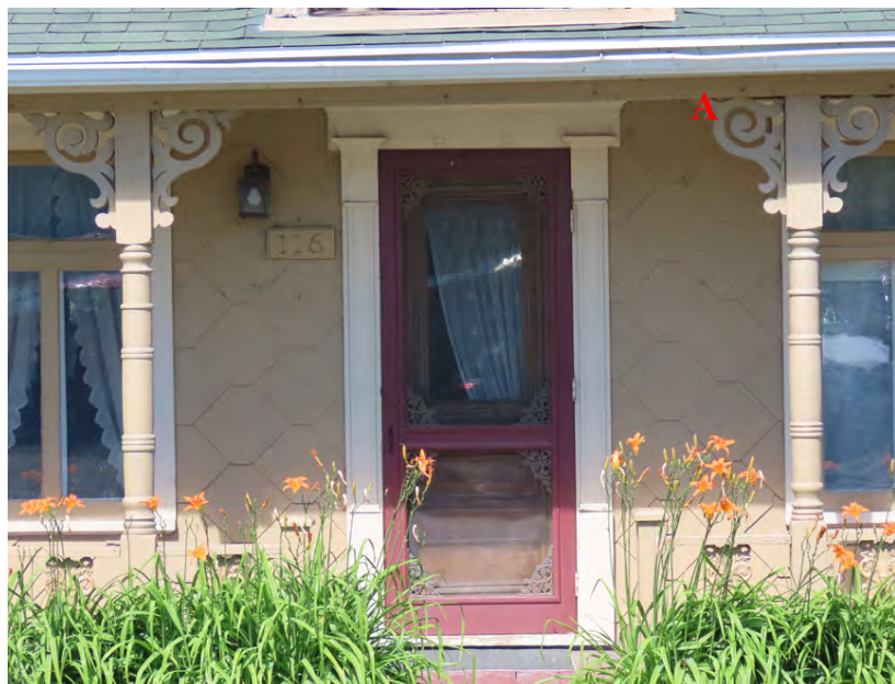
Aisseliers (A) et colonnes tournées, les incontournables des galeries de maisons patrimoniales. De beaux exemples au 116, 1 re Avenue Est, Saint-Martin. IMG_4277-L.jpg
