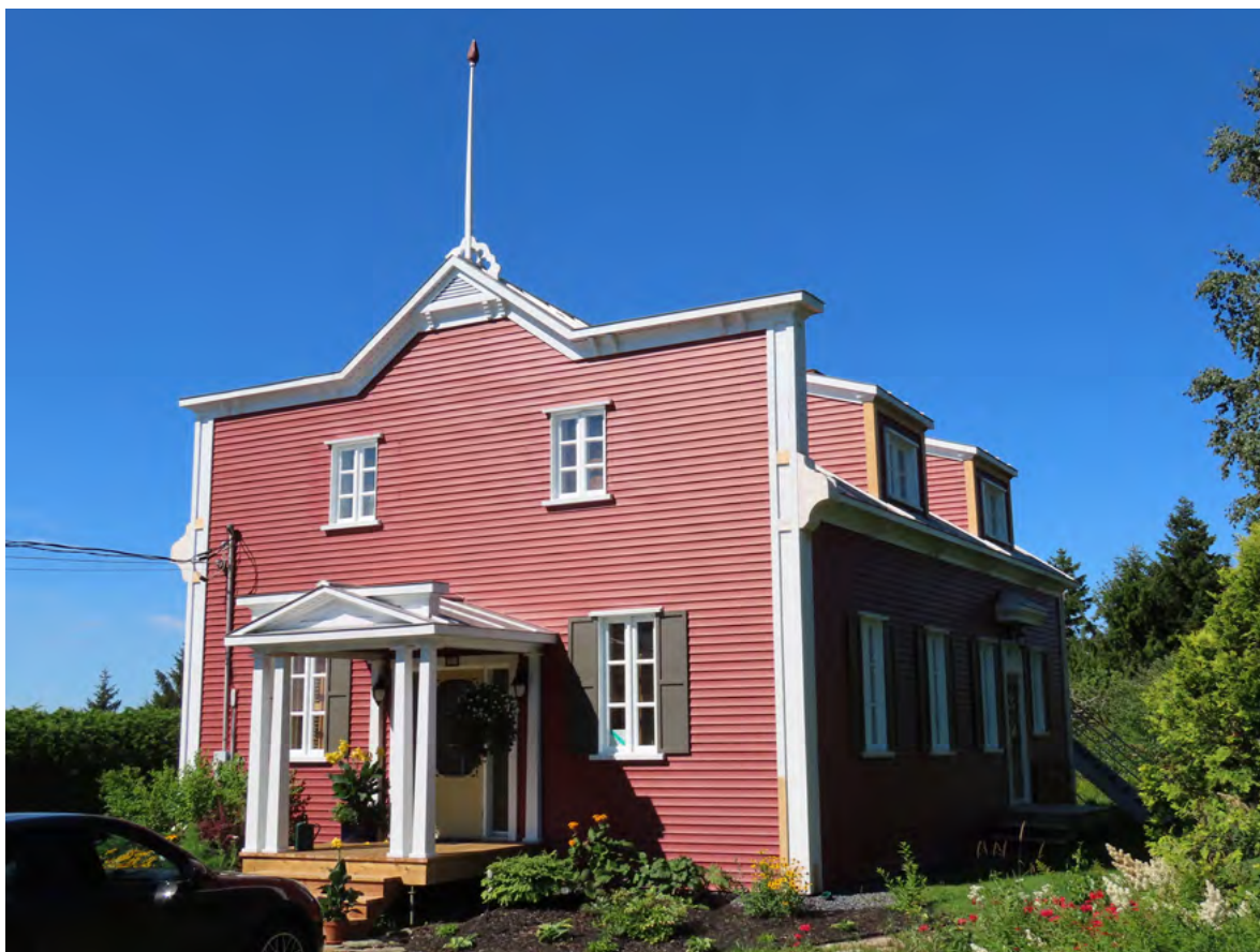
Bâtiment Boomtown, 874, rue Principale, Saint-Hilaire-de-Dorset. IMG_4765-L.jpg
