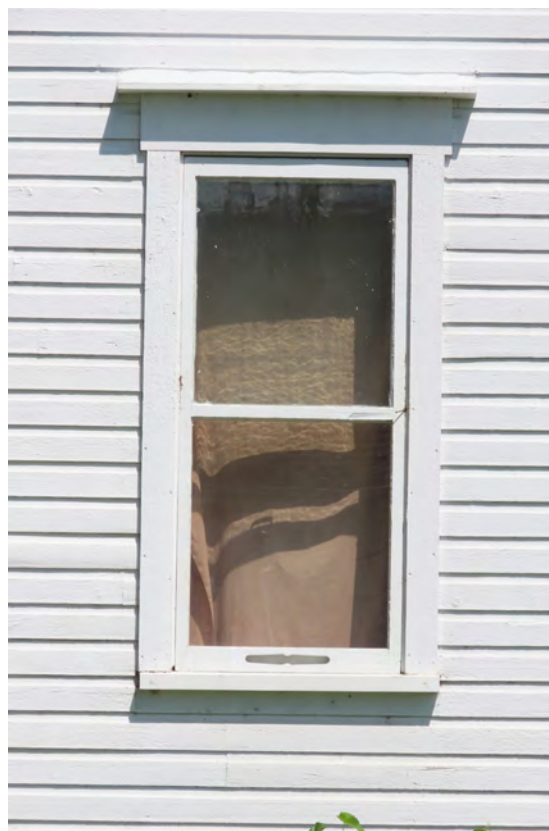
La fenêtre à guillotine « traditionnelle ». 123, 1 re Avenue Est, Saint-Martin. IMG_0877-K.jpg
