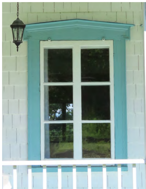
Contrefenêtre à six grands carreaux, devant des battants ouvrant par l'intérieur. 3175, chemin Royal, Notre-Dame-des-Pins. IMG_1005K.jpg
