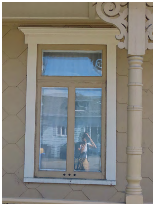
La fenêtre à battants à imposte : un modèle typique de la période 1910-1935. 116, 1 re Avenue Est, Saint-Martin. IMG_4278-L.jpg
