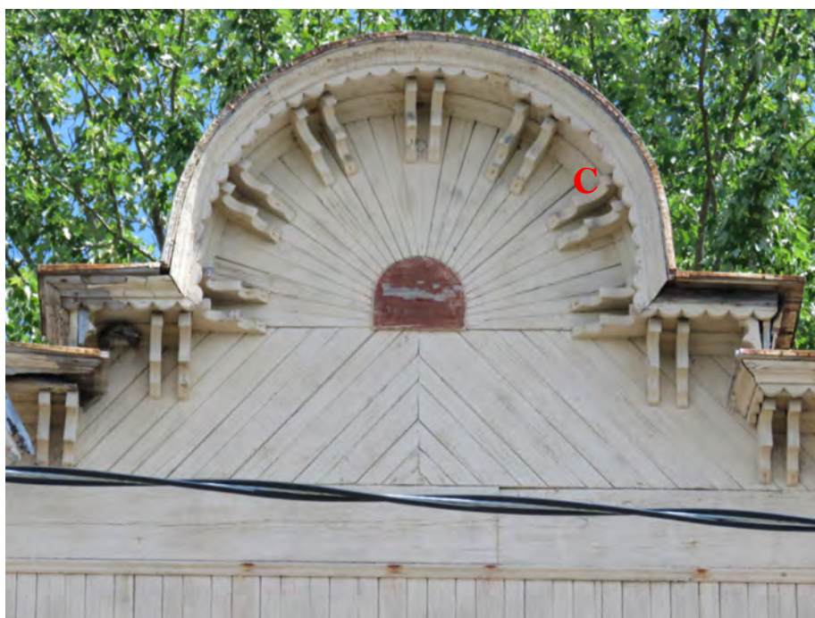
Fronton en arc plein cintre, finement élaboré et orné de consoles (C) doubles. img_0540-C.jpg
