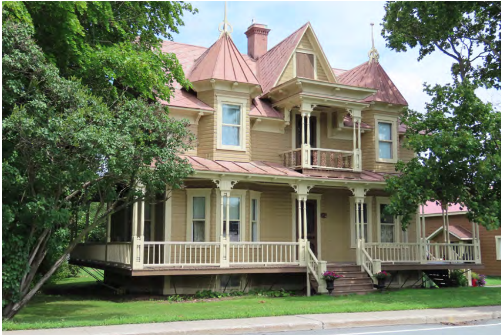
Le 351, rue Principale, Saint-Honoré-de-Schenley, un édifice exceptionnel par la qualité de sa composition architecturale. IMG_0674-K.jpg
