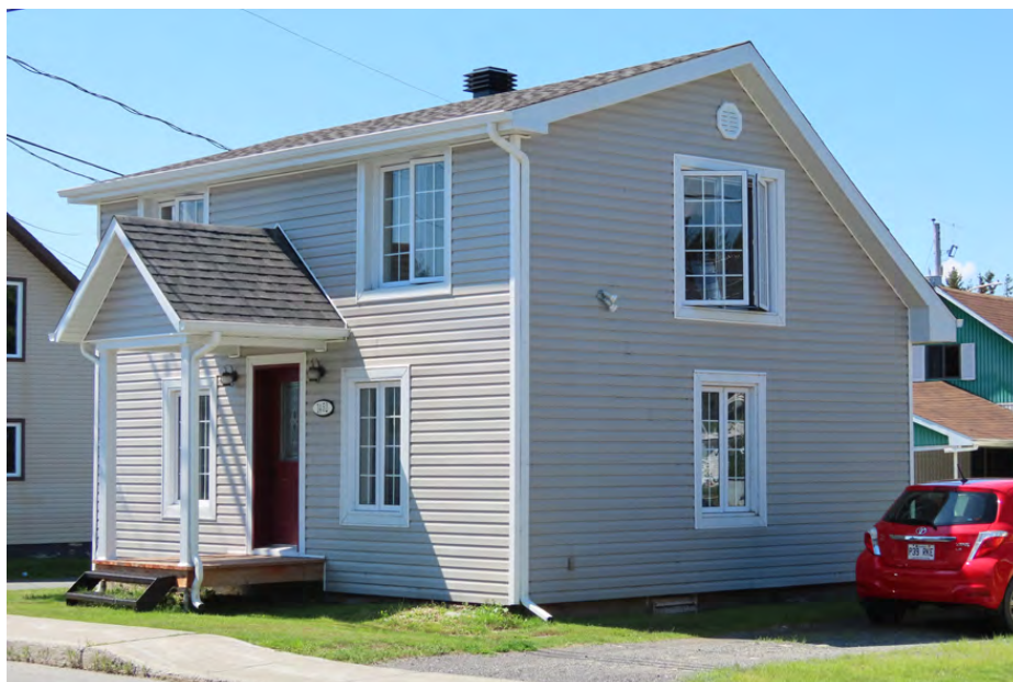
Le 1452, rue Principale, Saint-Côme-Linière. Photo : Bergeron Gagnon inc., 2020.
