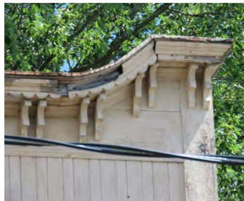
Extrémité du mur parapet orné de consoles doubles découpées. img_0541-C.jpg
