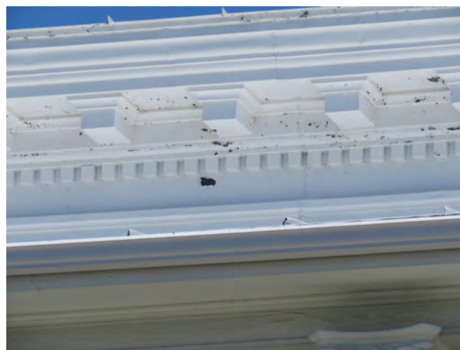
Détail des modillons et des denticules de la corniche. img_0288-C.jpg
