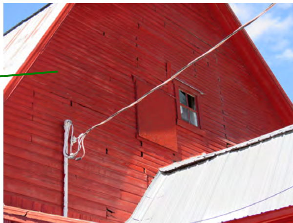
Parement de planche à feuilleure conservé au mur pignon droit du bâtiment ci-contre. img_0150-C.jpg
