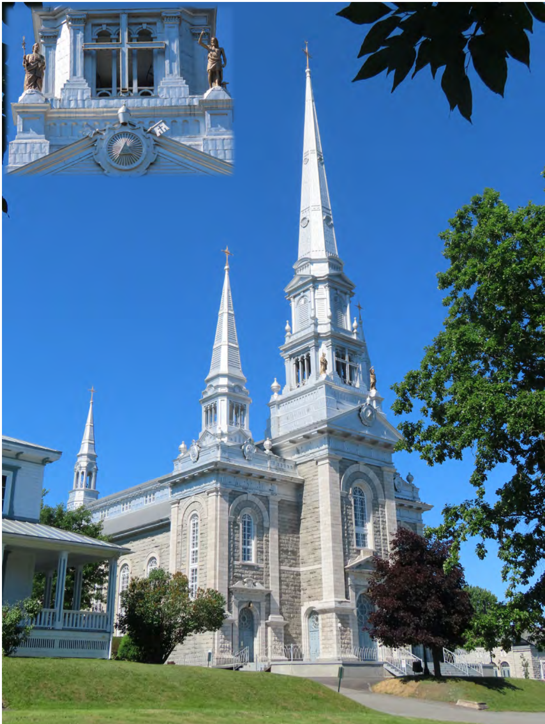
L'église de Saint-Georges, construite entre 1900 et 1902 selon les plans de l'architecte David Ouellet. Remarquable par sa qualité et son authenticité architecturale, elle est devenue un élément-phare pour la MRC de Beauce-Sartigan. 1840, 1 re Avenue Clermont-Pépin, Saint-Georges. img_3400-C.jpg
