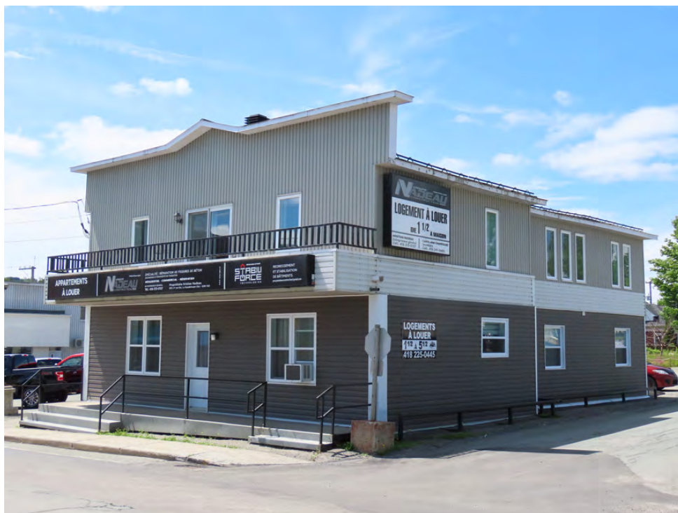
Le 521-527, 14 e Avenue, La Guadeloupe. Photo : Bergeron Gagnon inc. 2020. La fenestration, les revêtements et l'ensemble de la façade ont totalement été transformés.
