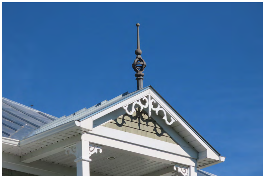
Epi trônant sur un fronton doté d'un ornement de pignon, un élément décoratif en bois découpé. 1563, 14 e Avenue, La Guadeloupe. IMG_1150k.jpg
