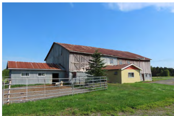
Grange-étable, au 565, route 108 Ouest, Saint-Ephrem-de-Beauce. IMG_1566K.jpg
