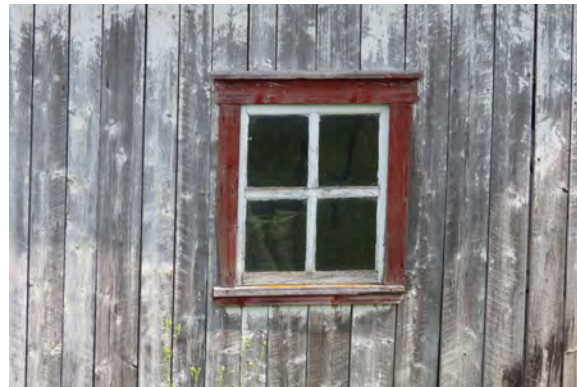
Revêtement de planche verticale au 390, route 271 Sud, Saint-Éphrem-de-Beauce. IMG_1699K.jpg
