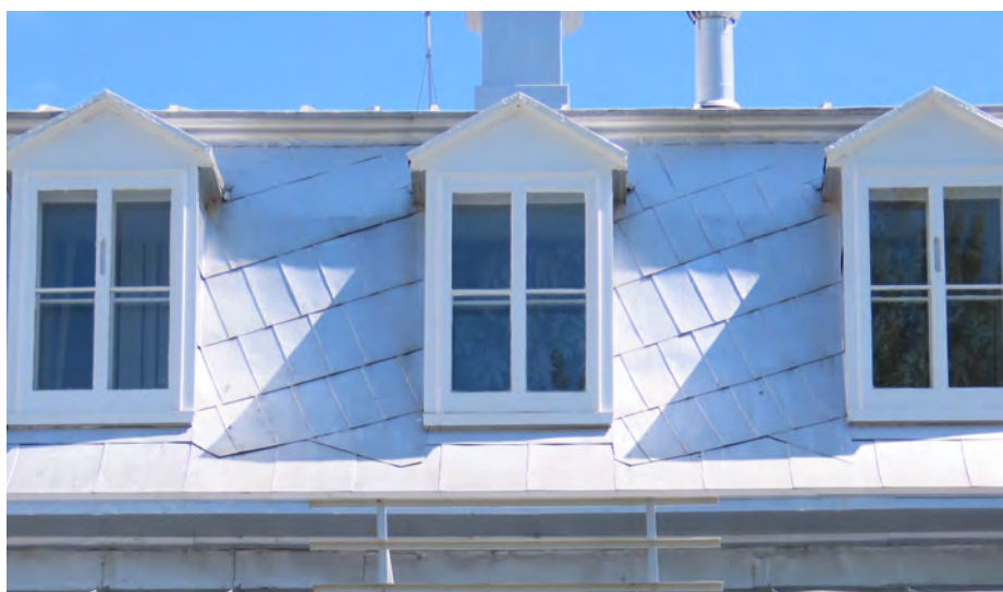
Tôle à la canadienne, remarquable par sa disposition angulaire sur le brisis de la toiture du presbytère de Saint-Côme-Linière. Le terrasson est quant à lui recouvert de tôle pincée. 1555, 19 e Rue, Saint-Côme-Linière. IMG_4127L.jpg
