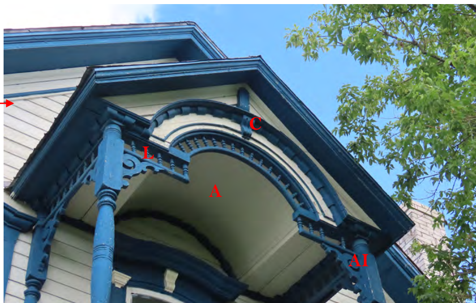
Un toit de balcon hors du commun : partie intérieure en arc (A) plein cintre, lambrequins (L), aisseliers (AI), consoles (C), colonnes tournées. Du grand art ! IMG_4340-L.jpg
