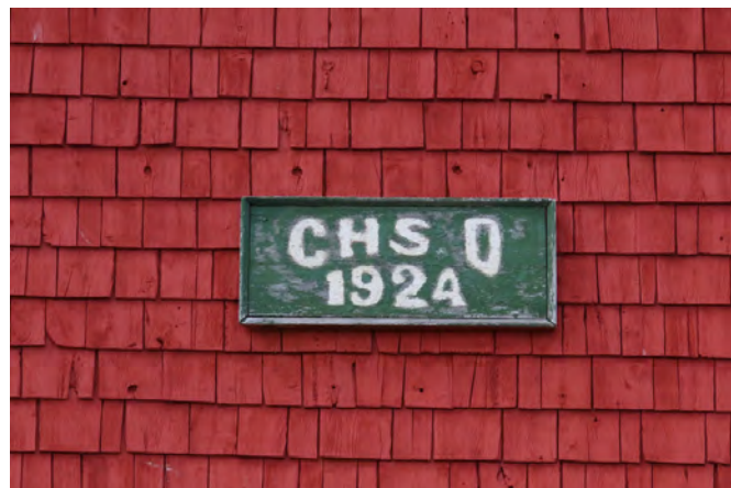
Portion très bien conservée du parement de bardeau de bois du bâtiment ci-contre. IMG_1586K.jpg
